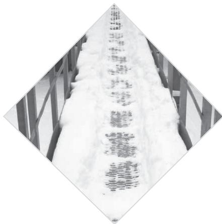
Рис. 2. Состояние ходового мостика из решетчатых настилов.
