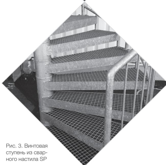
Рис. 3. Винтовая ступень из сварного настила SP
